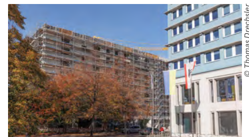
Der Rohbau des RuT-Wohnprojektes ist fertig.
