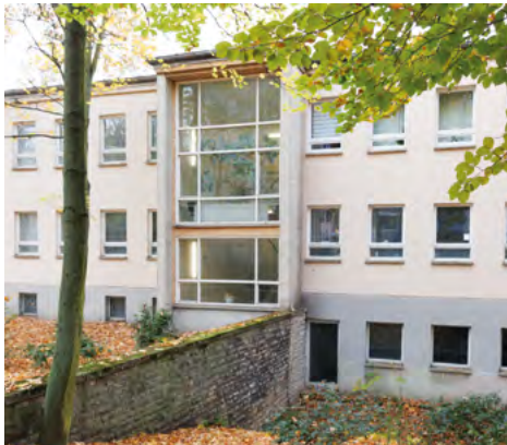
Das Treppenhaus von der Gebäuderückseite. Im Bild rechts die vorgelagerte Therapiewiese. Im Erdgeschoss (links) tagt monatlich der Nachbarratsrat KMA II e. V.
