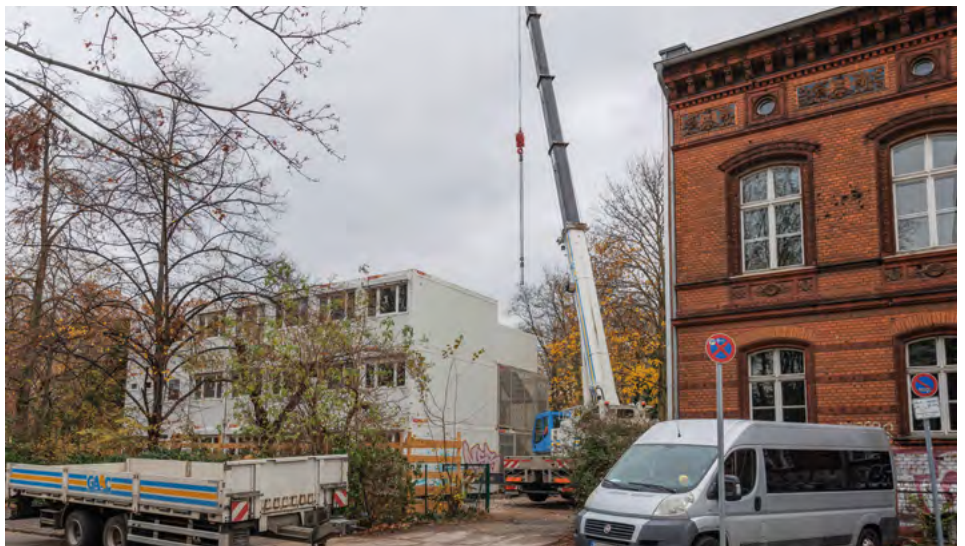
An der Ecke Singer-/Ifflandstraße entsteht derzeit ein temporärer Schulstandort. Die Container wurden Ende November aufgestellt.
