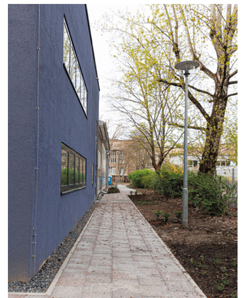
Hinter dem Sportgebäude wurde das für den Stadtteil typische Bernburger Pflaster verlegt. Auch die Lampen sind ein Nachbau entsprechend dem Materialeitfadens. Die Mulde wird zurzeit bepflanzt und zuletzt ein Anstrich mit Graffitienschutz aufgebracht.
