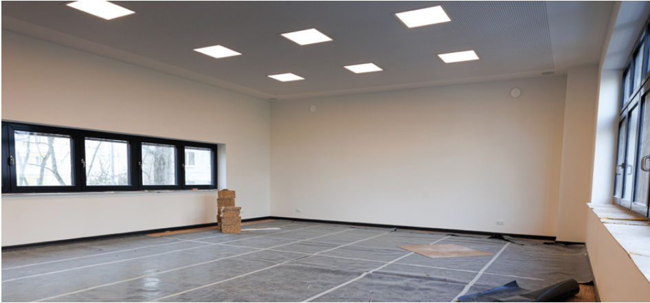
Der große Mehrzweckraum hat Licht zu beiden Seiten, Fußbodenheizung und Industrieparkett, das bis zur Eröffnung noch mit einem Schutzvlies abgedeckt ist.
