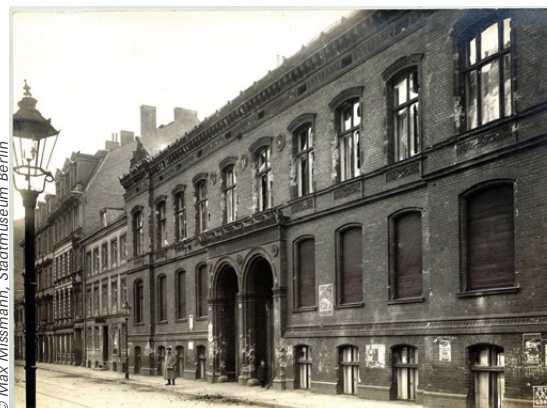
Gegenüber dem künftigen Neubau von RuT befand sich früher an der Elisabethstraße 57–58 das Königstädtische Gymnasium. Hier eine Aufnahme mit Gebäudeschäden nach den Straßenkämpfen März 1919
