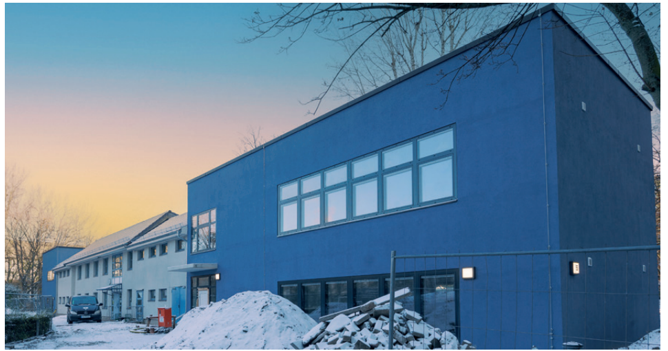
Das Funktionsgebäude auf dem Sportplatz Holzmarktstraße 55 wurden mit den beiden blauen Anbauten ergänzt. Im größeren Teil befinden sich beiden Mehrzweckräume (Foto rechts).
