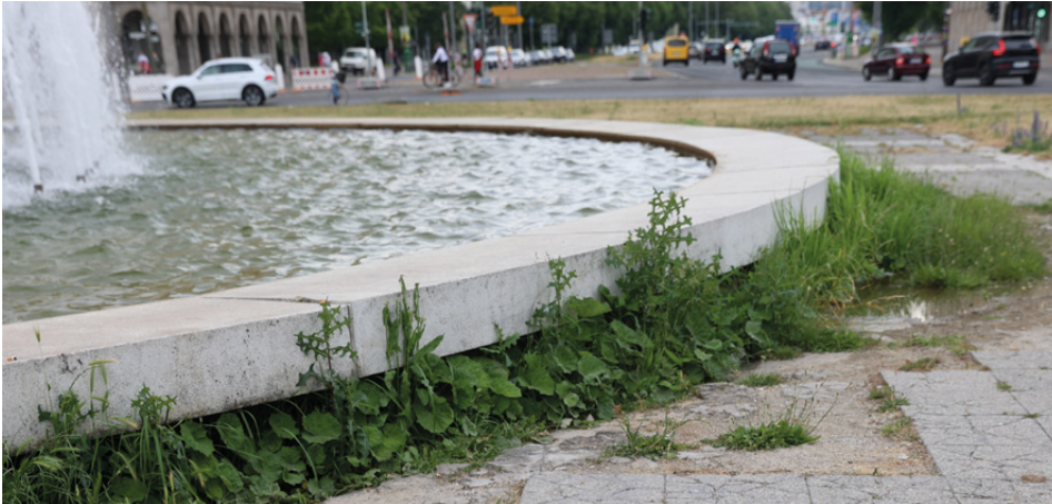
Um den „Schwebenden Ring“ von Fritz Kühn ist das Pflaster zerborsten, das Wasser sickert aus dem Becken und von den ursprünglichen Blumenbeeten ist nichts mehr zu sehen.
