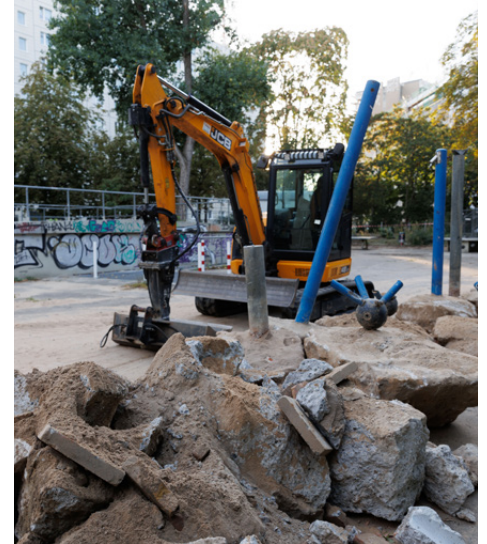
Die Erdarbeiten für den Spielplatz Berolinastraße sind im vollen Gange.
