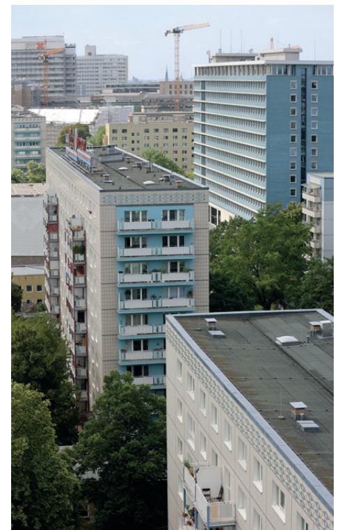
Deutlich erkennbar die durchgehenden Balkone an der Giebelseite des Zehngeschossers Karl-Marx-Allee 37–43. Im Vordergrund der Achtgeschosser Karl-Marx-Allee 47–51 mit dem gestalteten Drempegelgeschoss.
