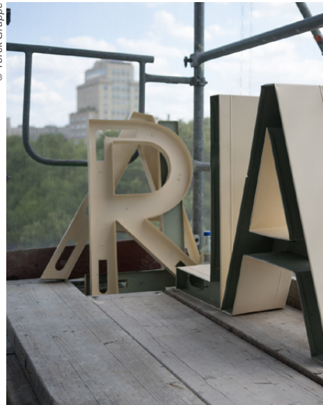
Die Fassaden wurden 2016 bereits saniert, nun folgt das Dach und später der Innenraum sowie die komplette Haustechnik.
