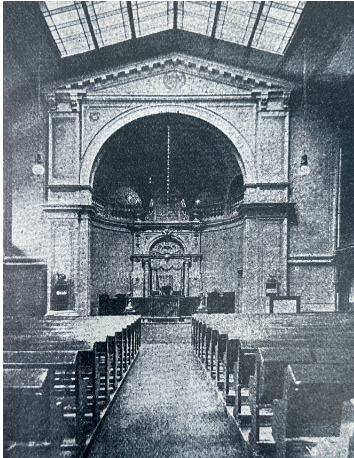
Das vermutlich einzige erhaltene Foto von der Orthodoxen Synagoge in der Kaiserstraße 29 (heute Alexanderstraße 23). Es zeigt die Inneneinrichtung von 1925.
