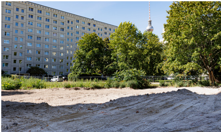
An dieser Stelle, an der Berolinastraße 9–11, entsteht das neue Wohnhaus für die Frauen der Initiative RuT.
