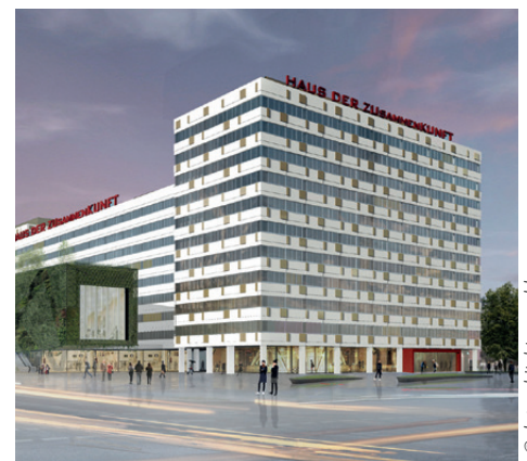
Das neue Haus der Zusammenkunft wird gegenwärtig umfangreich saniert.
