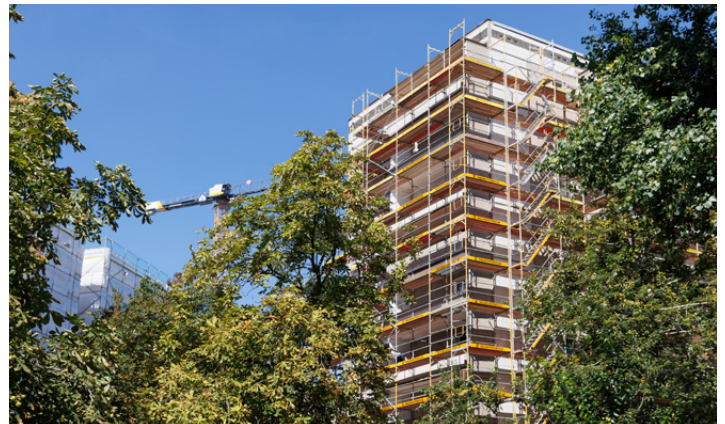
Am Wohnhaus Berolinastraße 20–21 geht inzwischen die Sanierung voran. Links im Bild einer von vier Kränen am Haus der Statistik.
