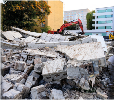
Bevor der Bagger am Pavillon Schillingstr. 2 anrücken konnte, mussten Arbeiter das Dach in Handarbeit abtragen. Die in den 1960er Jahren üblichen Dachpappen gelten heute als schadstoffbelastet.
