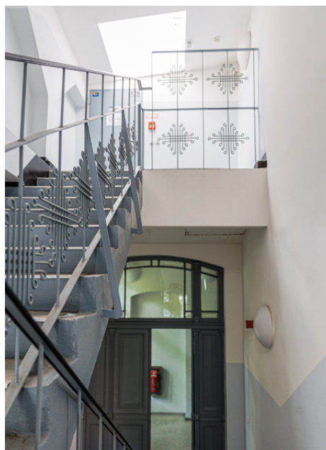
Das bereits sanierte Treppenhaus
