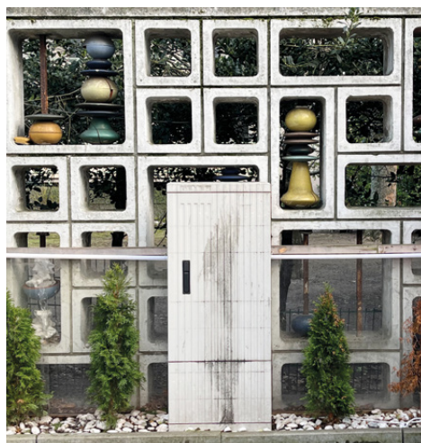
Die Wand vor der Sanierung: Zugestellt, überwuchert und verwittert
