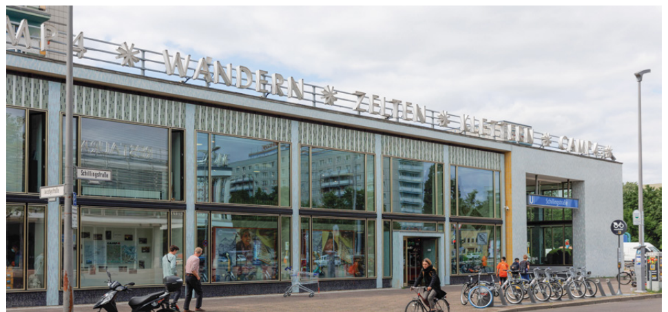
Die Beschriftung auf dem Dach wurde dem Original von Gebrauchsgrafiker Wittkugel angepasst
