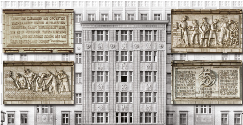
Relieftafeln an den Blöcken B-E, Bauabschnitt KMA I
