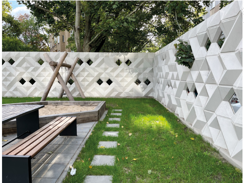
Die strahlend-weiße Strukturmauer mit neuem Fundament und schützendem Anstrich.
